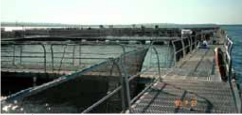
กระชังเลี้ยงปลาในทะเล (Marine Harvest's Tiwi Island) ที่ทำจากสแตนเลส เพื่อป้องกันจระเข้และฉลาม
