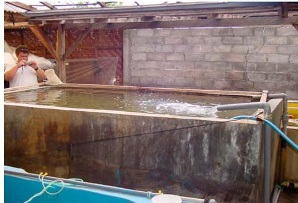
Tangki saringan pasir dari beton untuk hatcheri skala kecil-diperkirakan berkapasitas 10 m<sup>3</sup>
