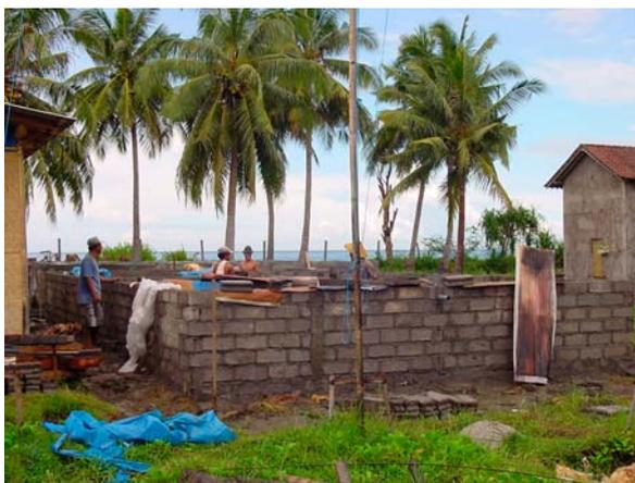
*Blok-blok beton yang digunakan untuk membuat tangki hatcheri untuk hatcheri skala kecil di Bali, Indonesia*
